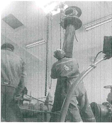
Imagen N°08: Bomba Hidráulica en mantenimiento
