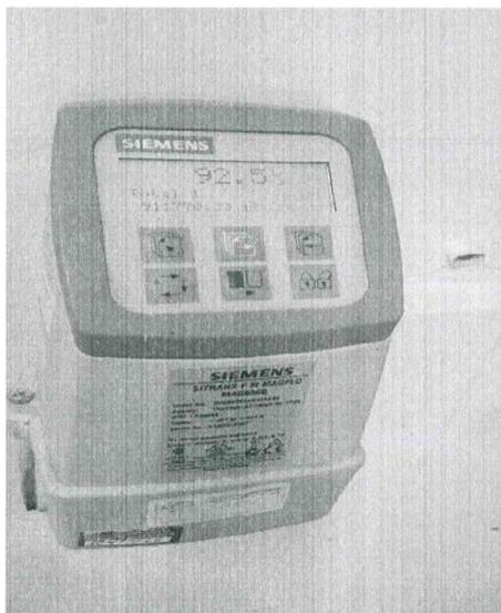
Imagen N°06: Medición de caudal de bombeo en Módulo II
