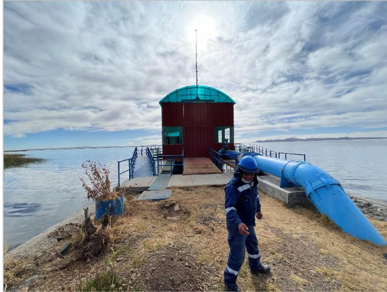
Imagen N° 5: Vista de la captación Chimú Nueva
