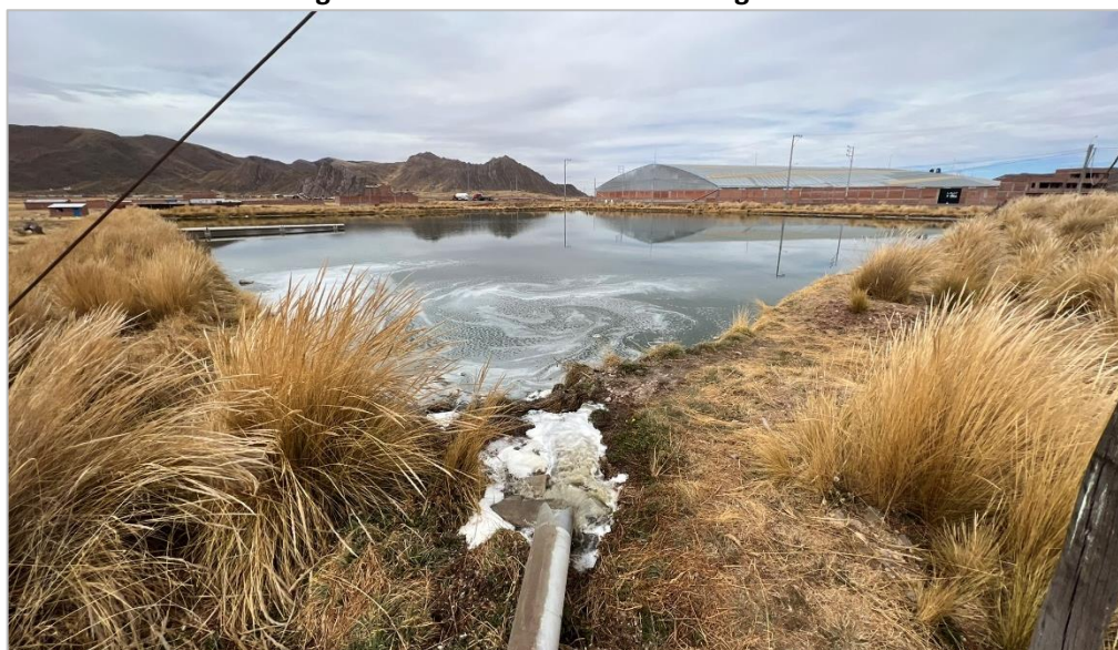
Imagen N° 16: Vista de la PTAR Desaguadero
