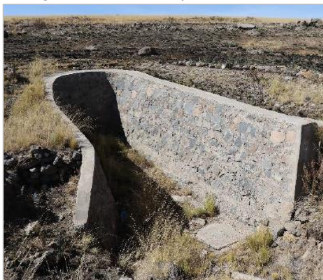
Imagen N° 6: Vista de la captación Chimú Nueva
