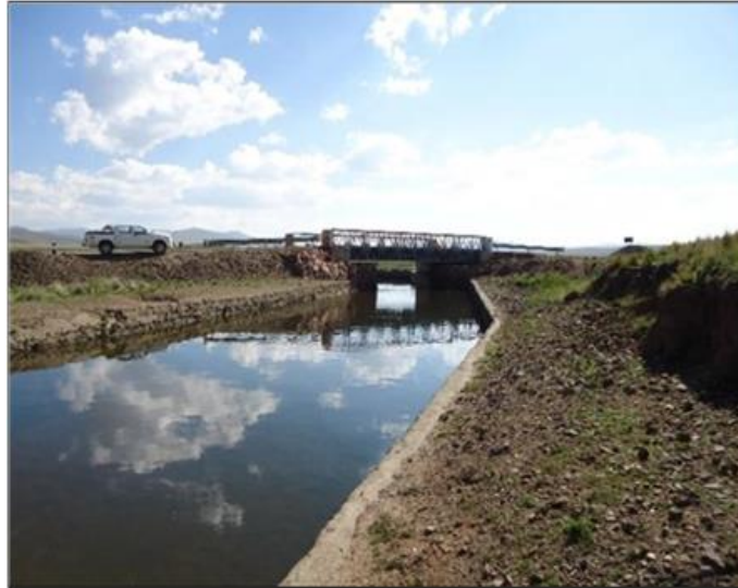
Figura 4: Ubicación Captación Totorani.
