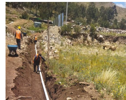
Suministro y tendido de tubería PVC-U en línea de impulsión PTAP -Reservorio
