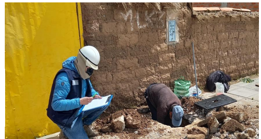
Solados concretos f'c=100 kg/cm 2 h=2" para fondo de caja de registro en reinstalación de micro medidores
