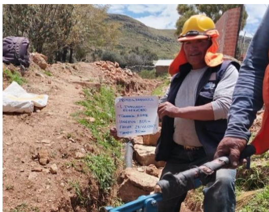
Prueba hidráulica de tubería hDPE 100mm en línea de impulsión PTAP - reservorio
