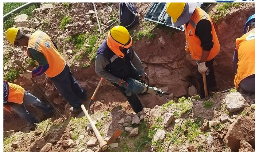
Excavación de zanja en terreno con roca fija
