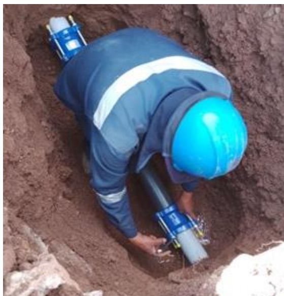
Instalación de unión dreseer
