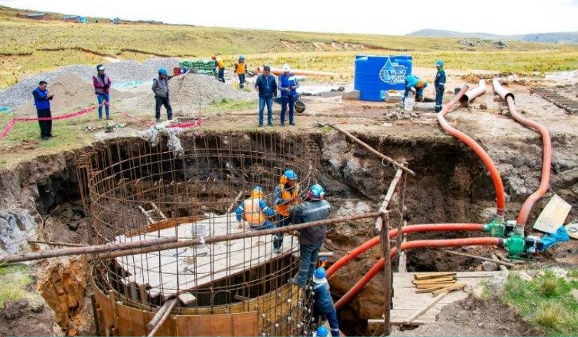
Encontrado y desencofrado de muro de caisson circular
