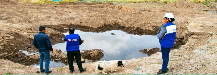
Verificación del relleno a la excavación del caisson anterior
