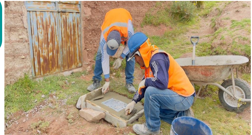
Encofrado de concreto en vereda nuevas instalaciones
