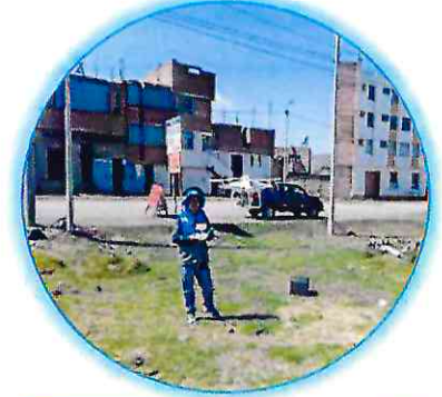
Levantamiento topográfico con DRON
