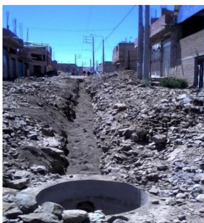
Ampliación de redes de alcantarillado
