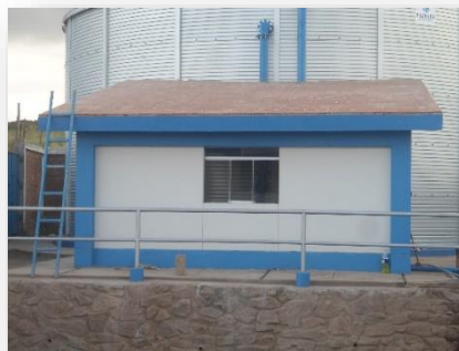
Caseta de válvula
