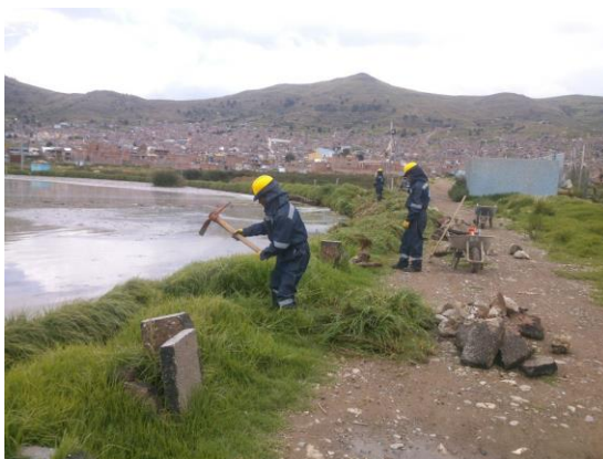
Trabajos preliminares de despejado de maleza
