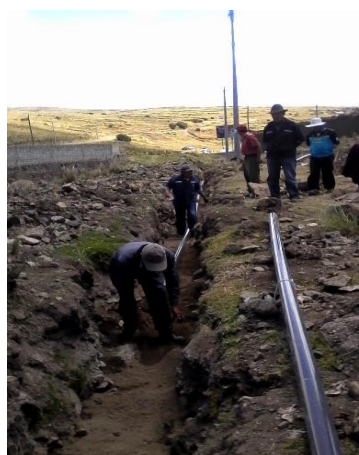
Ampliación de redes de agua potable
