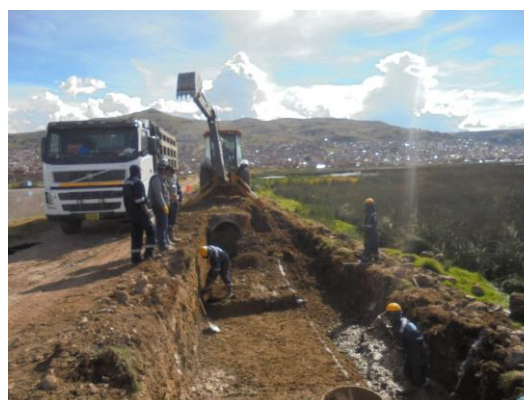
Excavación de zanja
