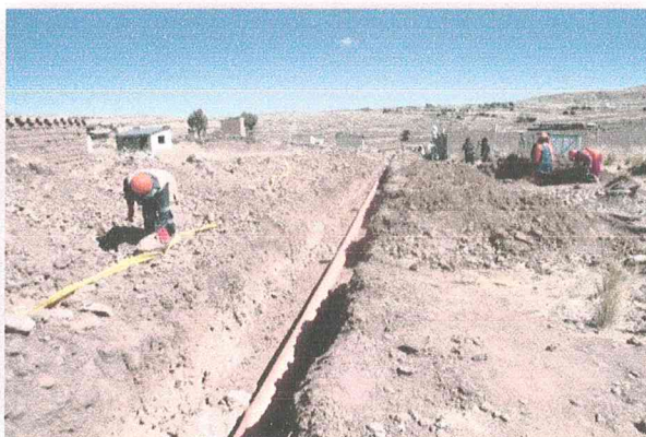
Tendido de tuberías de alcantarillado
