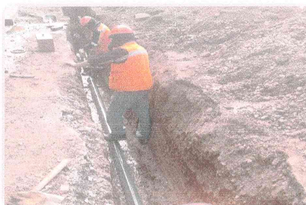
Instalación de nuevas tuberías de PVC diámetro de 110 mm c-10.
