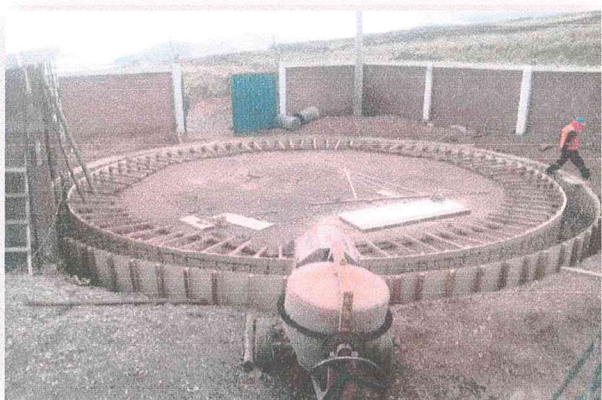
Construcción de la base del reservorio
