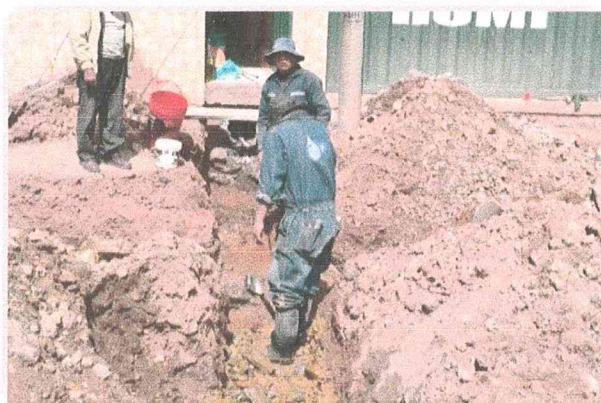
Ampliación de redes de alcantarillado en el barrio Sillustani, pasaje 6 de agosto de la ciudad de Puno beneficiando a 6 familias.
