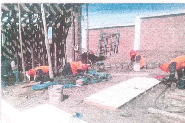
Obras civiles complementarias del proyecto
