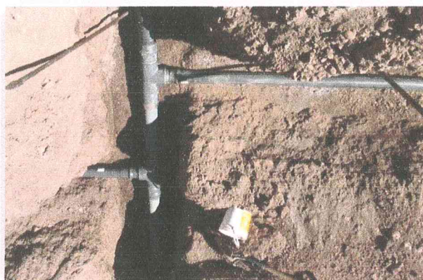
Ampliación de redes de agua e instalación de conexiones.
