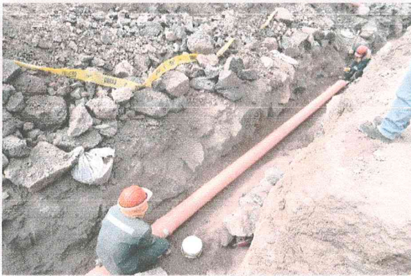
Tendido de tuberías de alcantarillado
