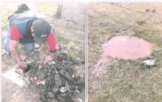
Limpieza y de válvula y buzón inundado
