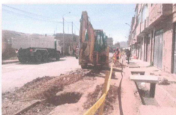
Excavación de zanjas para la renovación de redes de agua potable.
