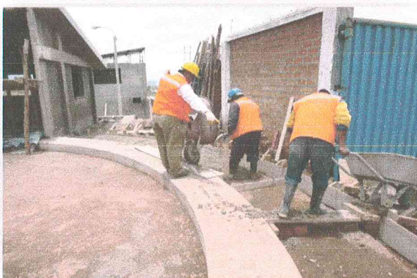
Construcción de la base del reservorio
