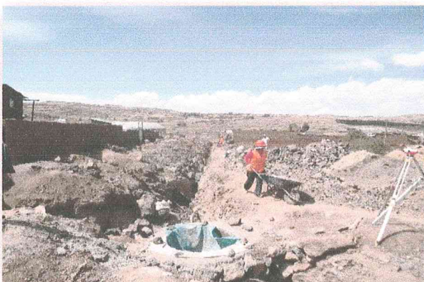
Excavación de Zanjas
