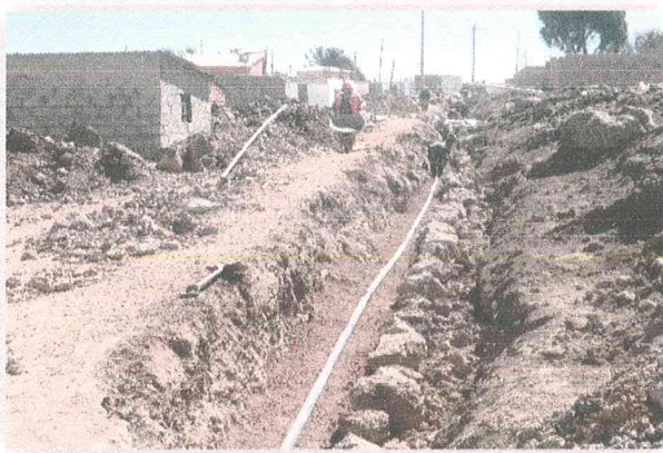
Tendido de tuberías de agua potable
