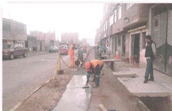
Relleno de zanjas con material propio seleccionado y pavimento.
