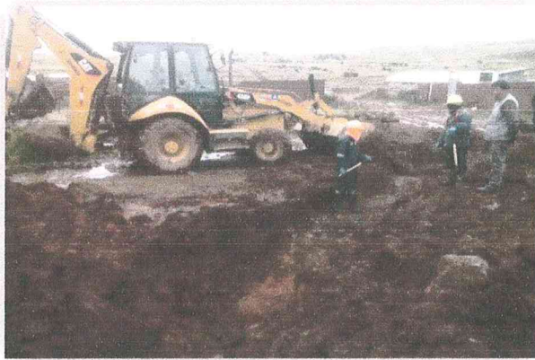
Apertura de zanjas.
