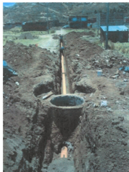
Tendido de tubería de alcantarillado
