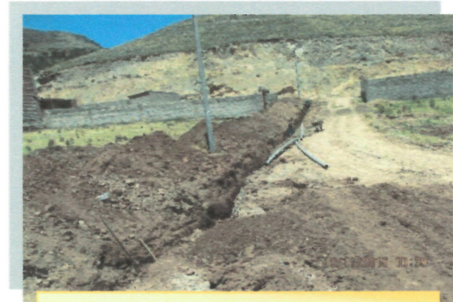
Tendido de tuberías
