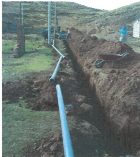
Colocación de cama de apoyo para posterior colocación de tuberías
