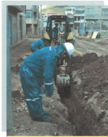
Excavación de zanjas
