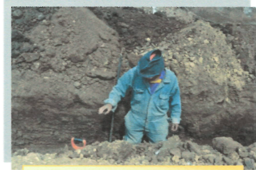
Excavación de Zanjas
