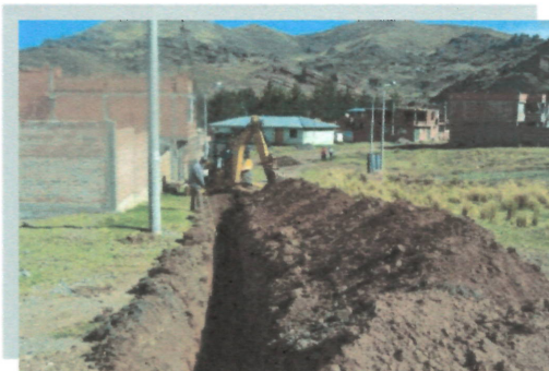
Excavación de zanjas
