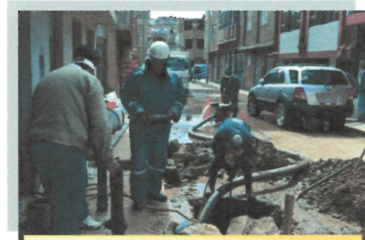
Reparación rotura de red de distribución red secundaria Jr. Vela Vela
