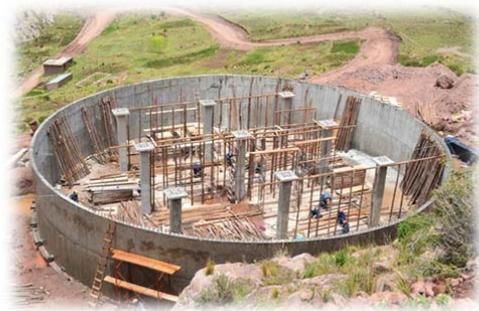
El avance físico en este componente es de 65.77%, se encuentra en proceso el vaciado del techo de concreto, la caseta de válvulas y los acabados correspondientes.
