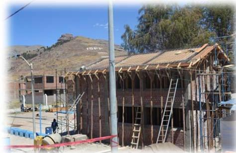
construido una caseta de bombeo con ladrillo mecanizado y reforzado con zapatas, columnas, vigas y losa de techo de concreto armado.
