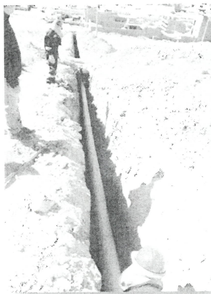
Colocación de redes colectoras de alcantarillado
