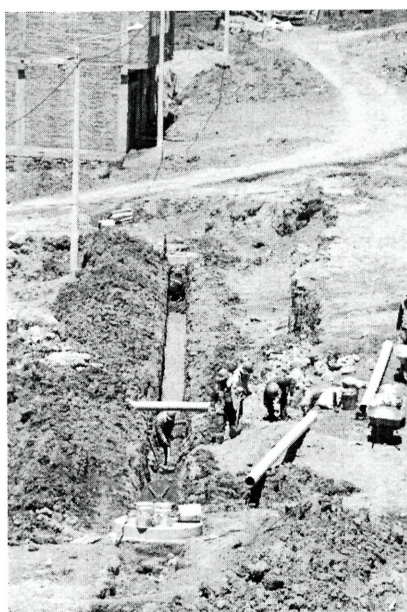
Instalación de tuberías
