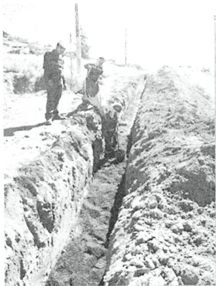
Relleno y cubierta con cama de arena
