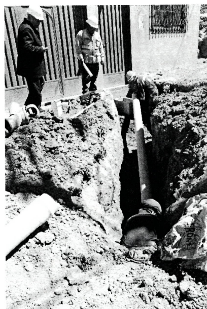
instalación de red secundaria para conexión conexiones domiciliaria
