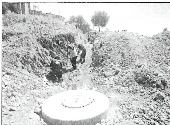
Se observa en imagen colocación de sobre cama para protección de tubería, relleno y compactación de zanjas. También se observa en imagen losa de techo de buzón acabada.
